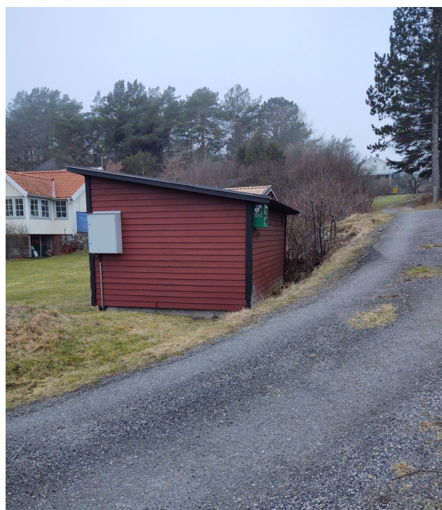
Källebacken Bakom pumphuset
